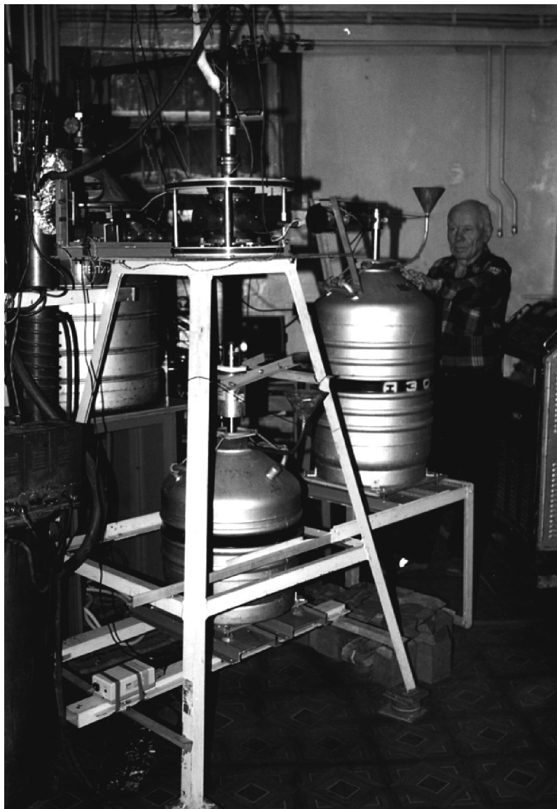
Рис. 35. Общий вид установки для наблюдения резонансного самопоглощения гамма-лучей ^{109m}\text{Ag}
