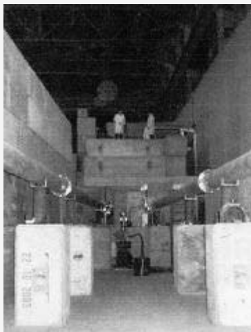
Вид пролетной базы 50 м
