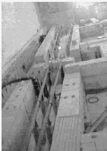
Вид на нейтронные каналы сверху
