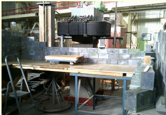
Рис. 51. Вид места для тестирования детекторов (9) (защитная рабочая (10) стена в процессе монтажа, коллиматор K_5 и тележка для системы контроля).
