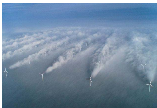
Рисунок 3 - Турбулентный след за ВЭУ пропеллерного типа
