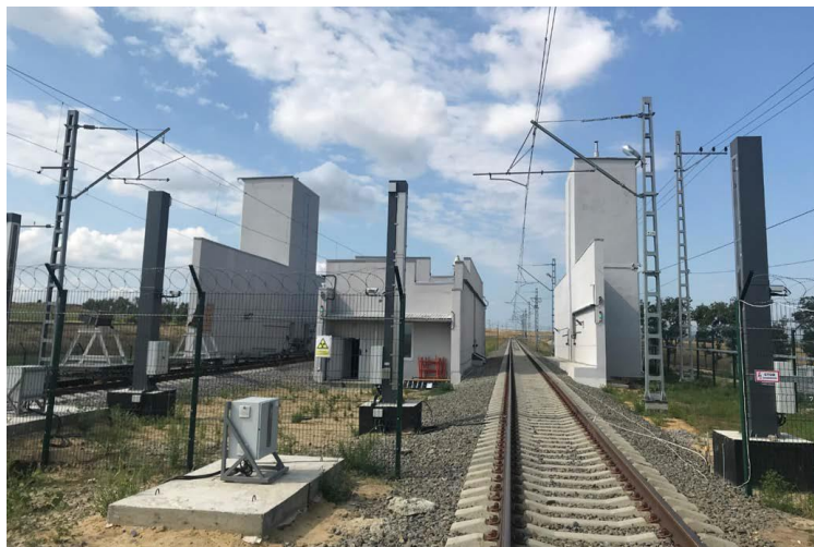
Двухпутевой ж-д ИДК
