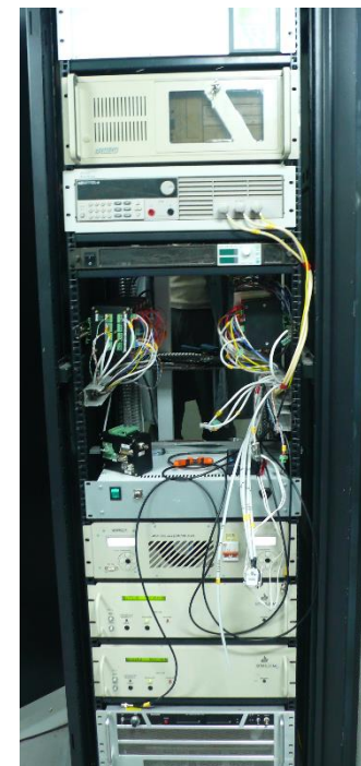
Система контроля и источники питания
